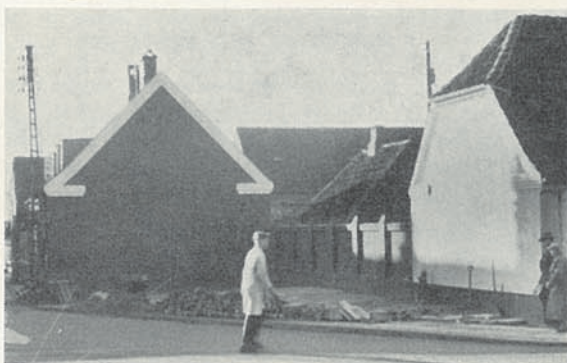
Saa faldt det gamle Hus paa Hjørnet af Torvet og Grønnegade. Billederne er taget før, under og efter Nedrivningen.
