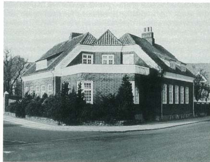
Den nedlagte Ørnhøjbanes driftsbestyrerbolig og kontorbygning, I. C. Christensens Allé 5. Nu tilhørende revisionsfirmaet H. P. Dalgaard og E. Husted. Fot. Ringkjøbing Museum, februar 1980.
