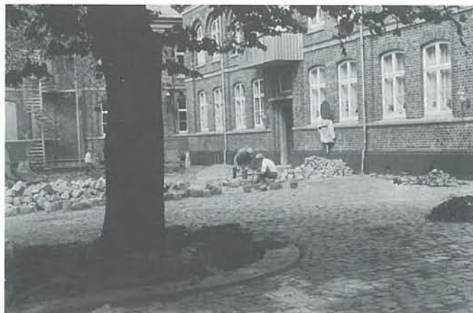
Kirkepladsen får i denne tid ny brolægning.
