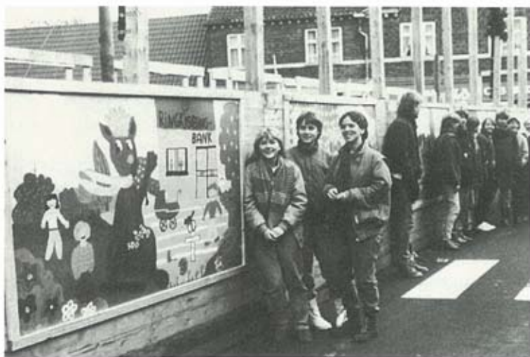
Englandsfarerne fik »entreprisen« på at male plankeværket omkring Ringkjøbing Banks byggeplads i Algade.
