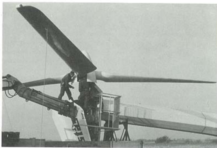
Vindmøllen er ved at blive gjort klar til rejsning ved rensningsanlægget på havnen.
