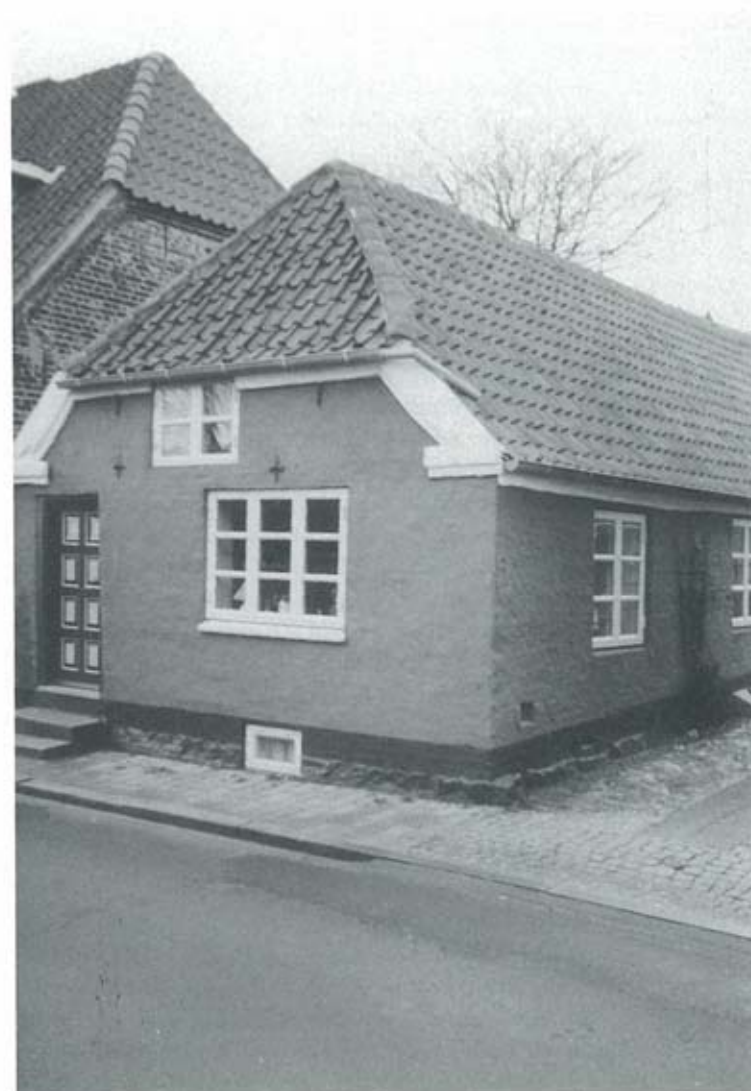
Kartefabrikken, som bygningen ser ud i dag. Oprindeligt var den i bindingsværk og med stråtag. Sokkelstenene er formodentlig de oprindelige.
