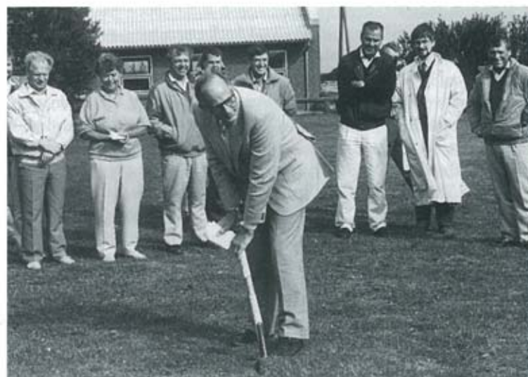
Borgmester Hans M. Jensen tager det første spadestik til ROFI-byggeriet.
