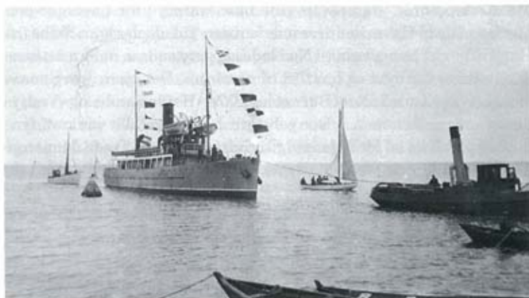
Den nye damper ankommer flagsmykket til Ringkøbing mandag den 25. juli 1921 på slæb efter Vandbygningsvæsenets lille damper »Ternen«. Kutteren til venstre har sikkert deltaget i bugseringen. Damperen var 42,9 m lang, 6,6 m bred, målte 178 BRT, havde 2 maskiner og 2 skruer, der ydede 600 hk og gav en topfart på ca. 12 knob. (Ringkøbing lokalhistoriske Arkiv).
