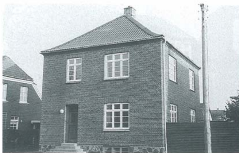
Tangsvej 16. Matr. nr. 142t. Bygget i 1931. Bygherre: Overportør Ivar Martinus Johan Andersen. Bygget af murermeister Jakob Chr. Moustesgaard og tegnet af dennes søn murer Viggo Moustesgaard.
