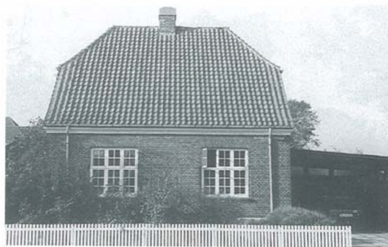
Tangsvej 5. Matr. Nr. 143n. Bygget i 1910. Bygherre: Sagfører og kreditforeningsfuldmægtig Christian Troense- gaard.
