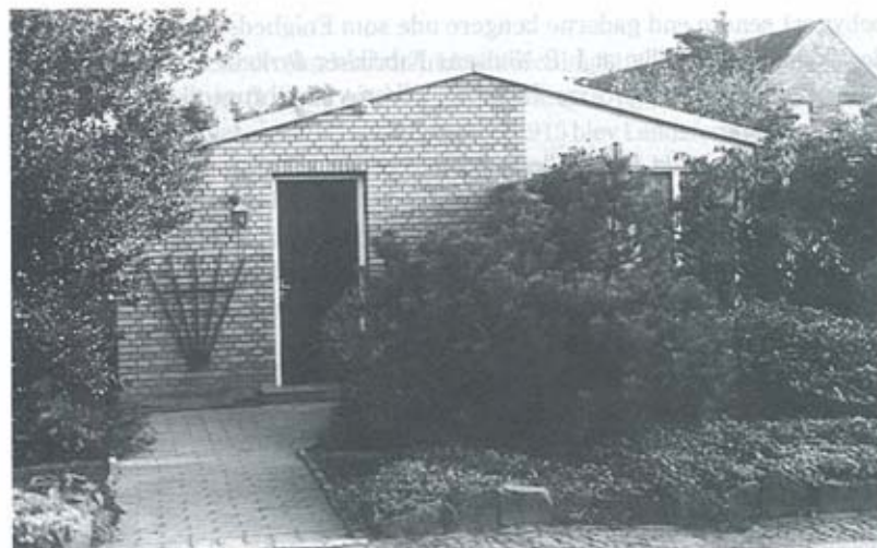
Tangsvej 4. Matr. nr. 142ag. Bygget i 1959. Bygherre: Malermester Kaj Birke. Arkitekt Brdr. Brockstedt-Christensen, Herning
