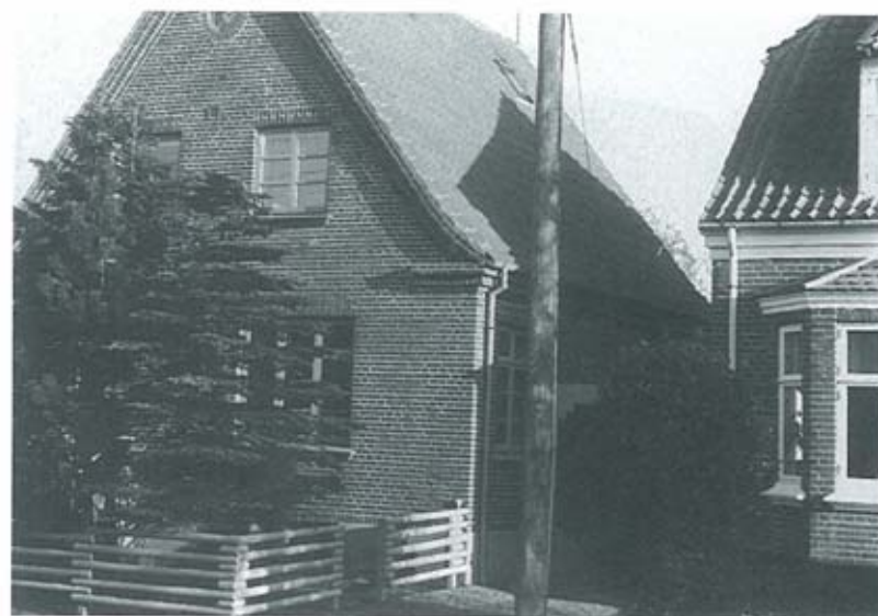
Tangsvej 20. Matr. nr. 142ac. Bygget i 1930-31. Bygherre: Toldbetjent Niels Møller.
