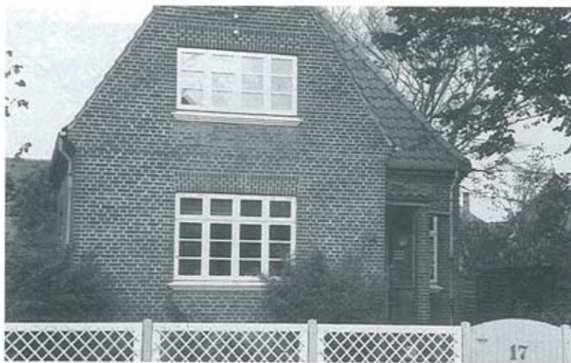
Tangsvej 17. Matr. nr. 143t. Bygget i 1931. Bygherre: Telegrafassistent Martin Mikkelsen. Bygmester og tegner som for nr. 16.
