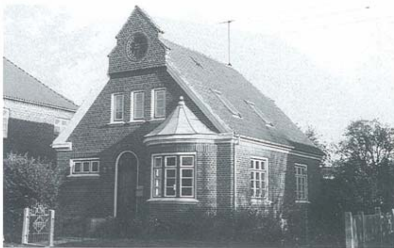
Tangsvej 14. Matr. nr. 142aa. Bygget i 1923. Bygherre: Tilskærer Søren Mikkelsen Hunnerup. Bygget af murermeister Jakob Chr. Moustesgaard.
